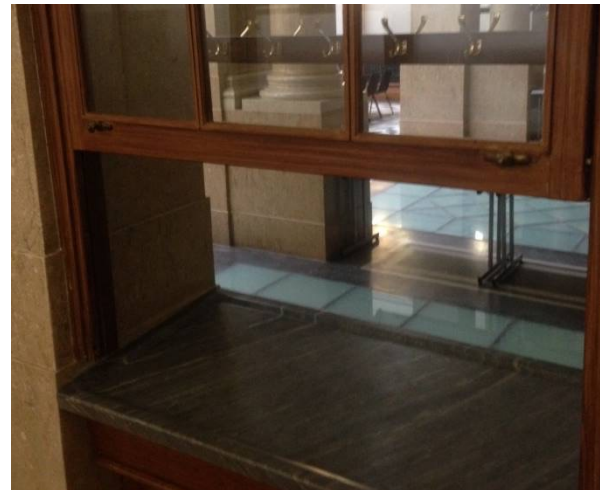
Schiebefenster zw Luftraum und Büros
