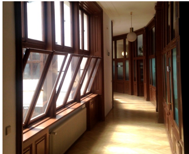
Kipfenster zw Luftraum und Büros
