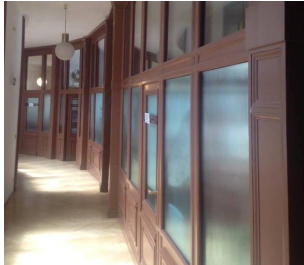
Bürotüren offenhalten für Nachtlüftung
