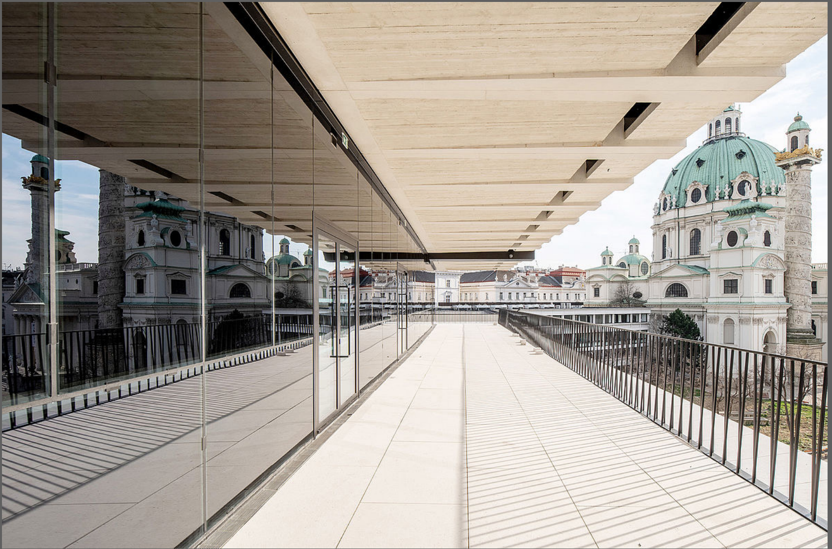
Einsatz von Sageglas im Fugengeschoß, Foto Kollektiv Fischka, März 2023
