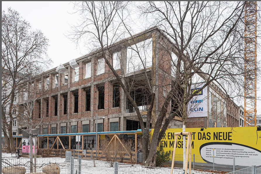
Entkernung 2020 beendet, Spatenstich für Umbau Juli 2020
