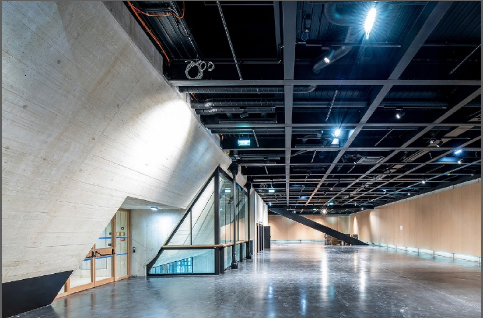
Gussbetonboden und Vorsatzwände im Sonderausstellungsgeschoß, Foto Kollektiv Fischka, März 2023
