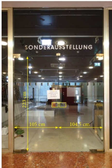
Türgriffe Bereits demontiert
