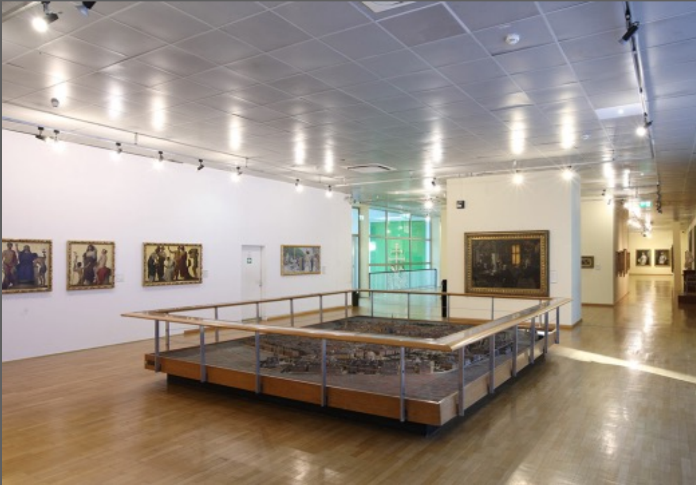
Beleuchtung mit Halogen Strahlern vor dem Umbau
